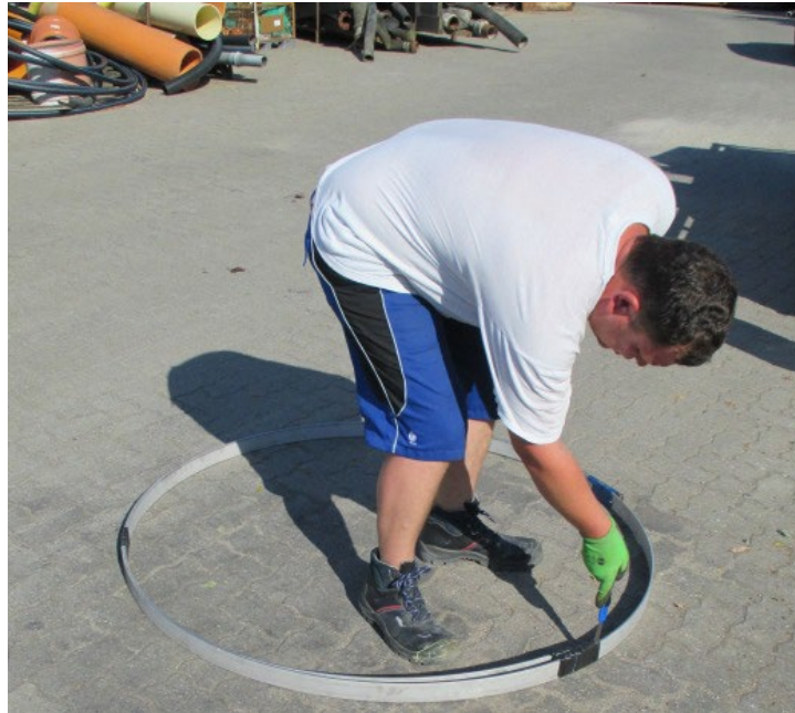
Entfernen der Transportsicherung
