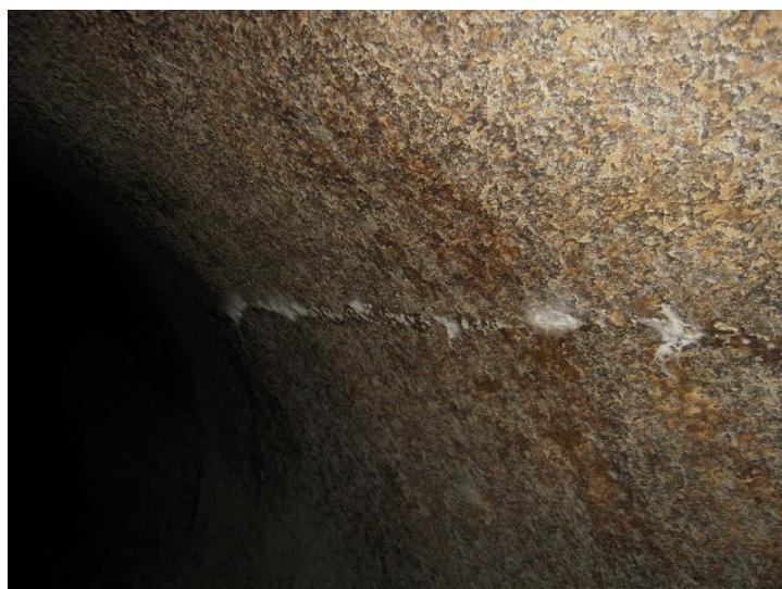
Schadenskontrolle, Längsrisse
