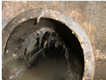
Abbildung 19: Wurzeleinwuchs
