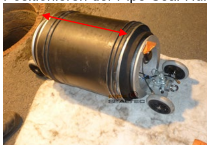
Abbildung 53: Positionieren der vorbereiteten Edelstahlhülse auf dem Versetzpacker
