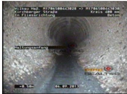
Abbildung 17: Betonkorrosion
