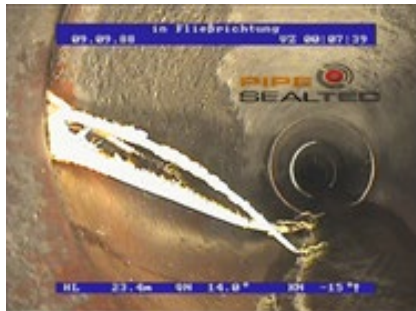
Abbildung 18: Wurzeleinwuchs
