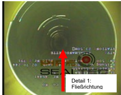
Abbildung 54: Anordnung Bördelung
