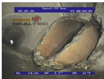
Abbildung 15: Einragender Stutzen
