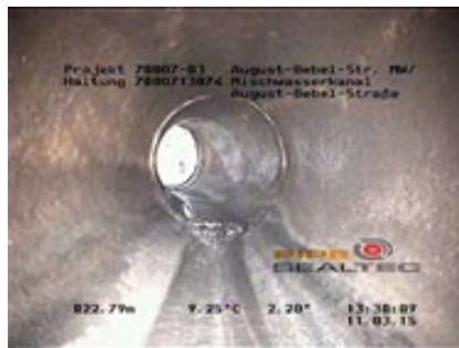
Abbildung 14: Axiale Richtungsänderung
