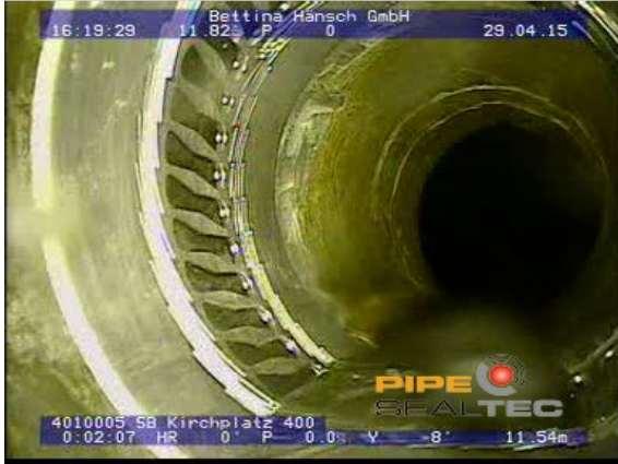
Abbildung 87: Sanierung mit Pipe-Seal-Flex bei Abwinklung
