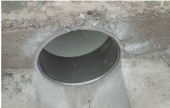
Abbildung 20: Lineranbindung mit Pipe-Seal-End
