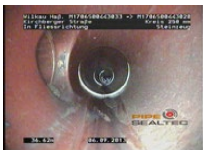
Abbildung 16: Abzweigformstück
