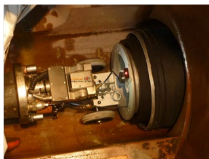
Abbildung 58: Einfahrt zu Einbauort im Kanal
